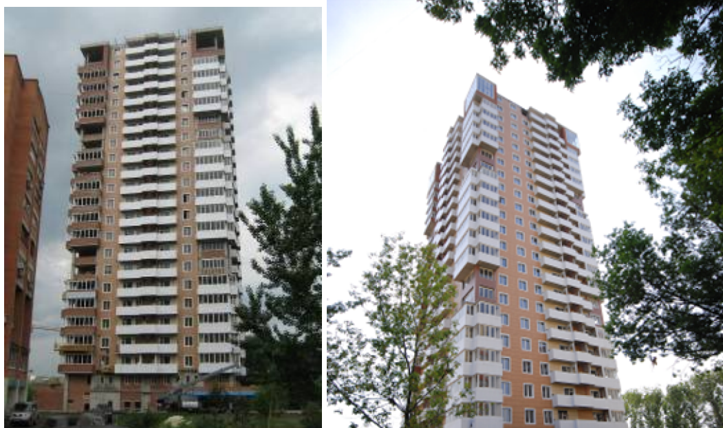
Житловий будинок №1 по пр. Панфілова у м. Донецьку станом на 29.05.2009 р. та станом на вересень 2009 р.
