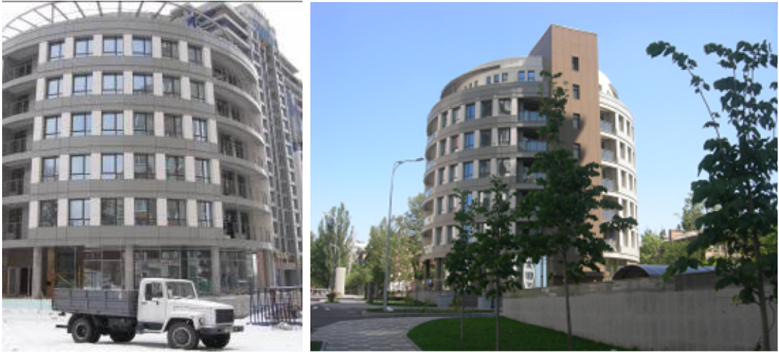
Хід робіт з будівництва ж/б 1 по вул. Професора Підвисоцького у Печерському районі м. Києва станом (зліва-направо): на 18.03.2010 р. та на 08.06.2010 р.
