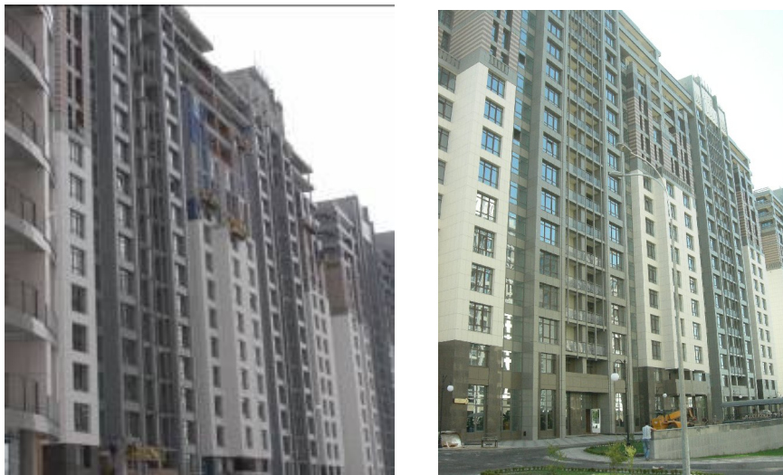
Хід робіт з будівництва ж/б 2 по вул. Професора Підвисоцького у Печерському районі м. Києва станом (зліва-направо): на 18.03.2010 р. та на 08.06.2010 р.
