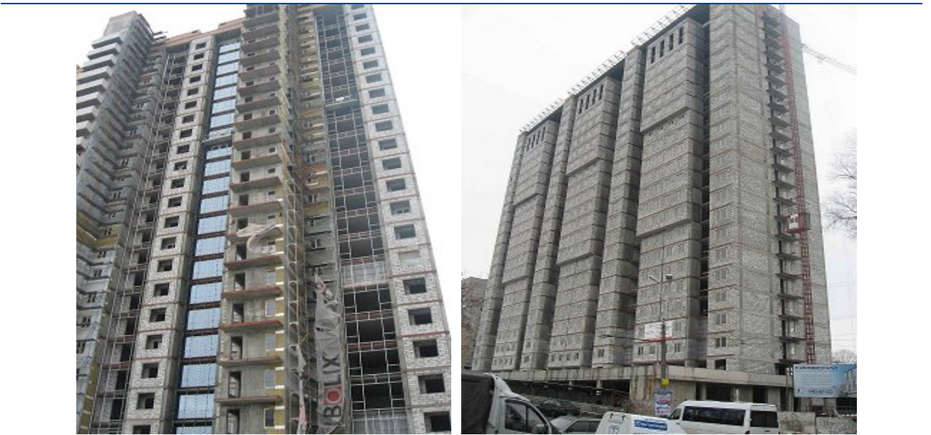
Хід робіт на об'єкті будівництва по вул. Ульянова, в районі буд. 17 А у м. Дніпропетровську станом на 10.02.2009 р.
