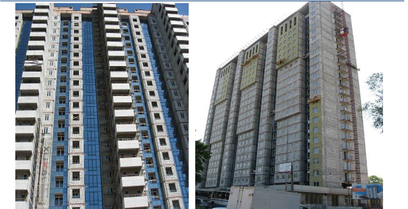
Хід робіт на об'єкті будівництва по вул. Ульянова, в районі буд. 17 А у м. Дніпропетровську станом на 20.05.2009 р.
