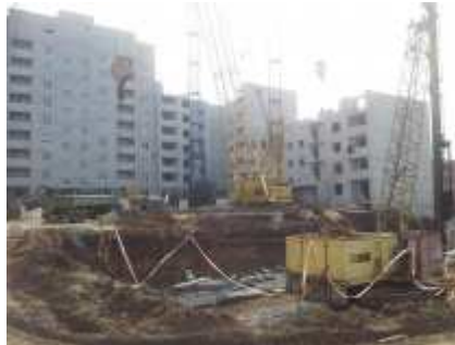
Хід будівництва житлових будинків №5, №6 по вул. Дача-55 у м. Харкові станом на початок I кварталу 2014 року
