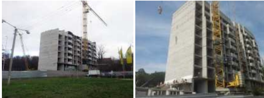
Хід будівництва житлового будинку по вул. Клочкіській, 46 у м. Харкові станом на початок 2014 року та на середину липня 2014 року (зліва направо)
