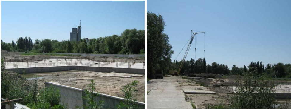
Будівництво готельно-житлового комплексу з приміщеннями соціально-побутового призначення по проспекту Академіка Глушкова, 926 у м. Києві станом на початок червня 2009 року
