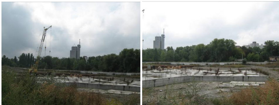
Будівництво готельно-житлового комплексу з приміщеннями соціально-побутового призначення по проспекту Академіка Глушкова, 926 у м. Києві станом на вересень 2009 року
