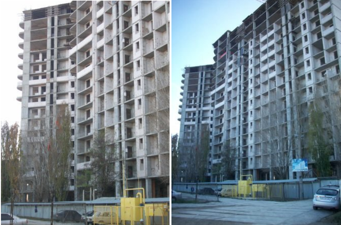
Рисунок 1. Будівництво житлового будинку по вул. Ак. Корольова, 5/2 у м. Одесі станом на кінець листопада 2009 року
