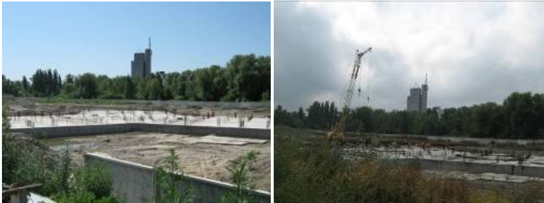
Будівництво готельно-житлового комплексу з приміщеннями соціально-побутового призначення по проспекту Академіка Глушкова, 926 у м. Києві станом (зліва - направо) на початок червня 2009 року та на вересень 2009 року
