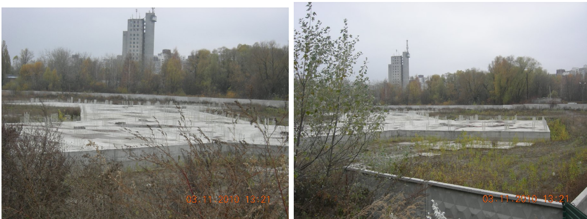
Будівництво готельно-житлового комплексу з приміщеннями соціально-побутового призначення по проспекту Академіка Глушкова, 926 у м. Києві станом на листопад 2010 року
