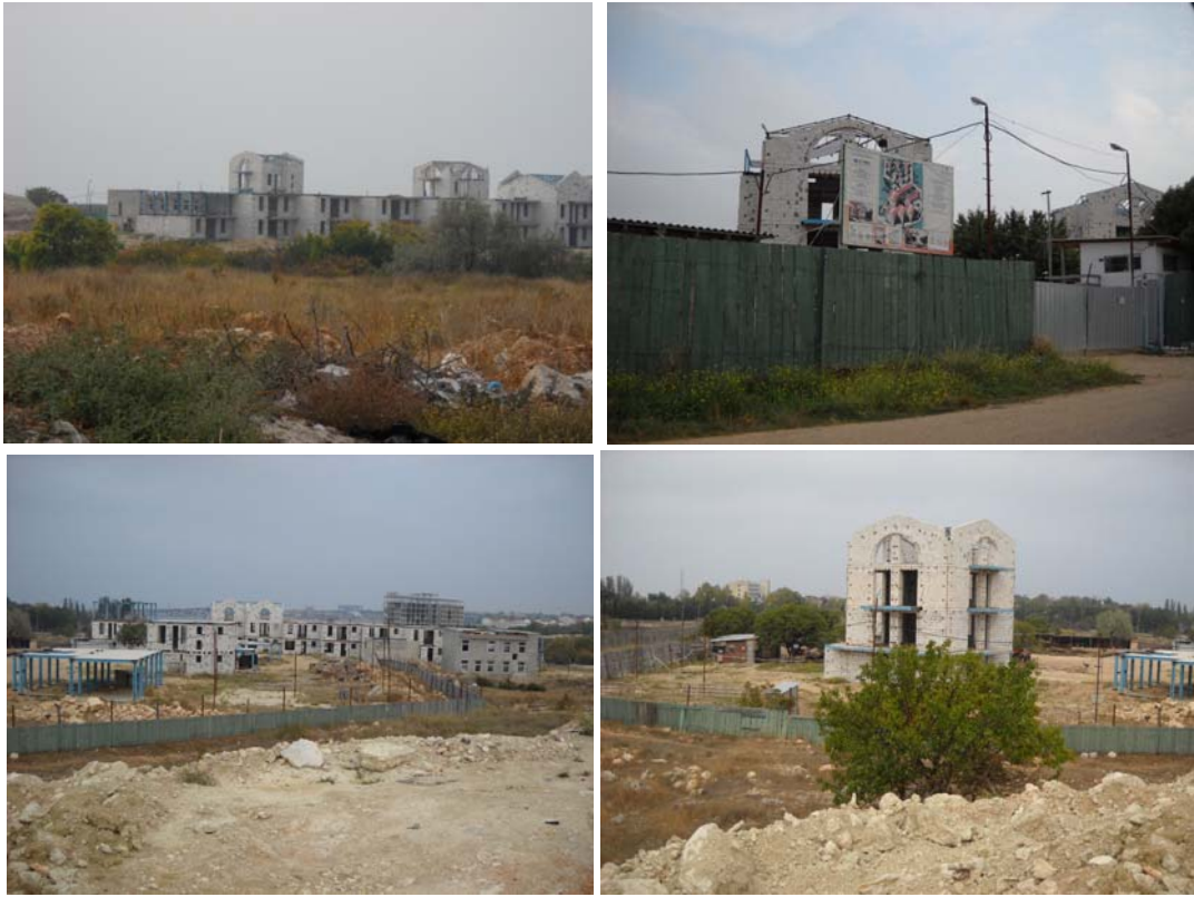
Будівельні роботи із зведення пансіонату котеджного типу в бухті «Омега» у м. Севастополі на початок жовтня 2009 року
