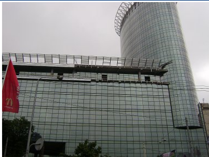
Хід робіт на об'єкті будівництва по вул. Мельникова, 2/10, станом на 18.11.2010 р.
