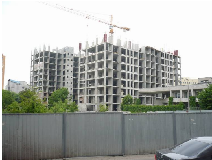
Хід робіт на об'єкті будівництва по пров. Ламаному в м. Дніпропетровську станом на 10.06.2009 р.
