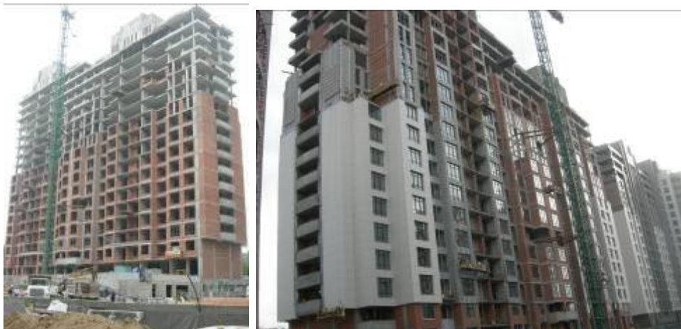
Хід робіт з будівництва ж/б 2 по вул. Професора Підвисоцького у Печерському районі м. Києва станом (зліва-направо): на 03.09.2009 р. та на 19.11.2009 р.
