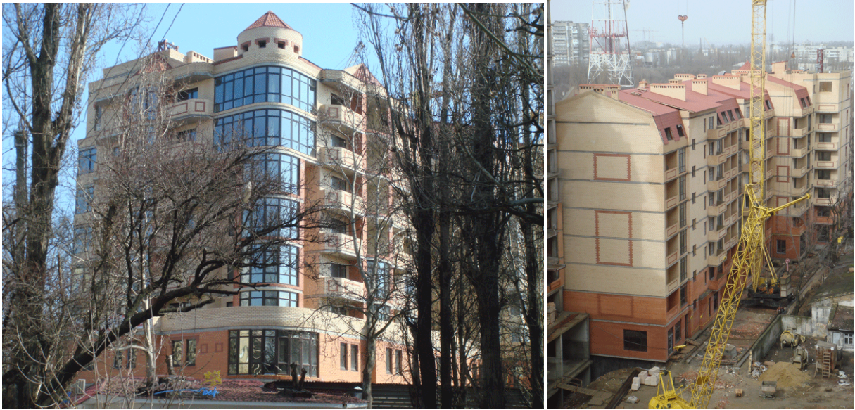
Будівництво 7-ми поверхового корпусу житлового комплексу «Армійський» в м. Одесі станом на 21.03.2009 р.
