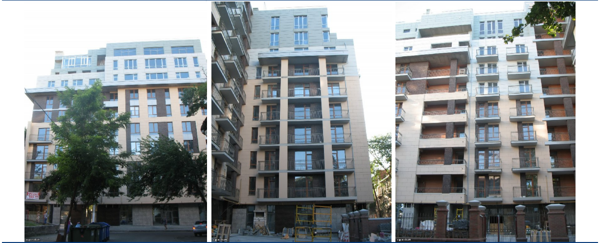
Будівництво житлового будинку по вул. Відрадній, 13 станом на кінець серпня 2011 року
