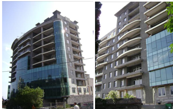
Рисунок Ошибка! Текст указанного стиля в документе отсутствует..2. Хід робіт на об'єкті будівництва житлового комплексу «Адміралтейський» класу «люкс» по вул. Руданського, буд. 8 Б станом на початок червня 2009 року
