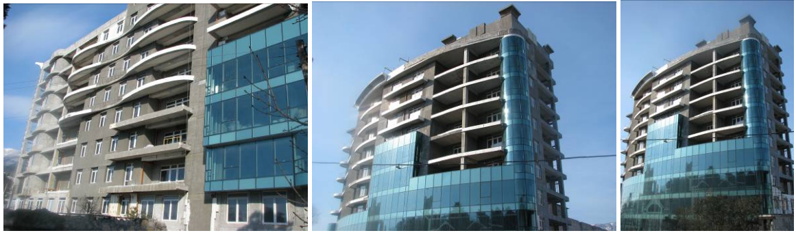
Рисунок Ошибка! Текст указанного стиля в документе отсутствует..1. Хід робіт на об'єкті будівництва житлового комплексу «Адміралтейський» класу «люкс» по вул. Руданського, буд. 8 Б станом на 20.02.2009 р.
