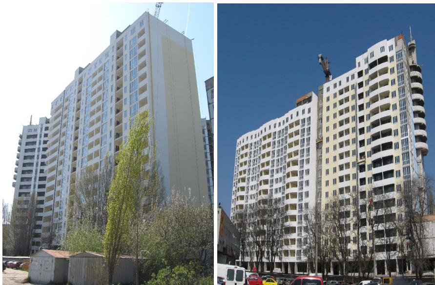
Рисунок 1. Будівництво житлового будинку по вул. Ак. Корольова, 5/2 у м. Одесі станом на 27.04.2011 р.
