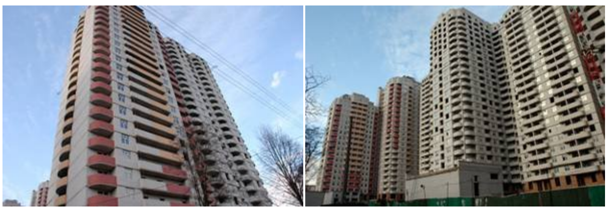
Рисунок 1. Будівельні роботи по вул. Майорова, 5А
