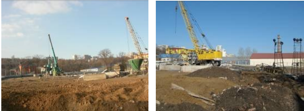
Рисунок Ошибка! Текст указанного стиля в документе отсутствует..2. Хід робіт на об'єкті будівництва (I черга) по вул. Набережній Перемоги, в районі буд. № 40 у м. Дніпропетровську станом (зліва-направо) на кінець листопада 2008 р. та на середину лютого 2009 р.
