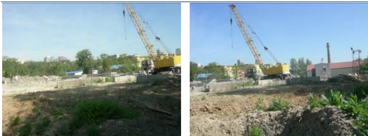
Рисунок Ошибка! Текст указанного стиля в документе отсутствует..3. Хід робіт на об'єкті будівництва (I черга) по вул. Набережній Перемоги, в районі буд. № 40 у м. Дніпропетровську станом на середину травня 2009 р.
