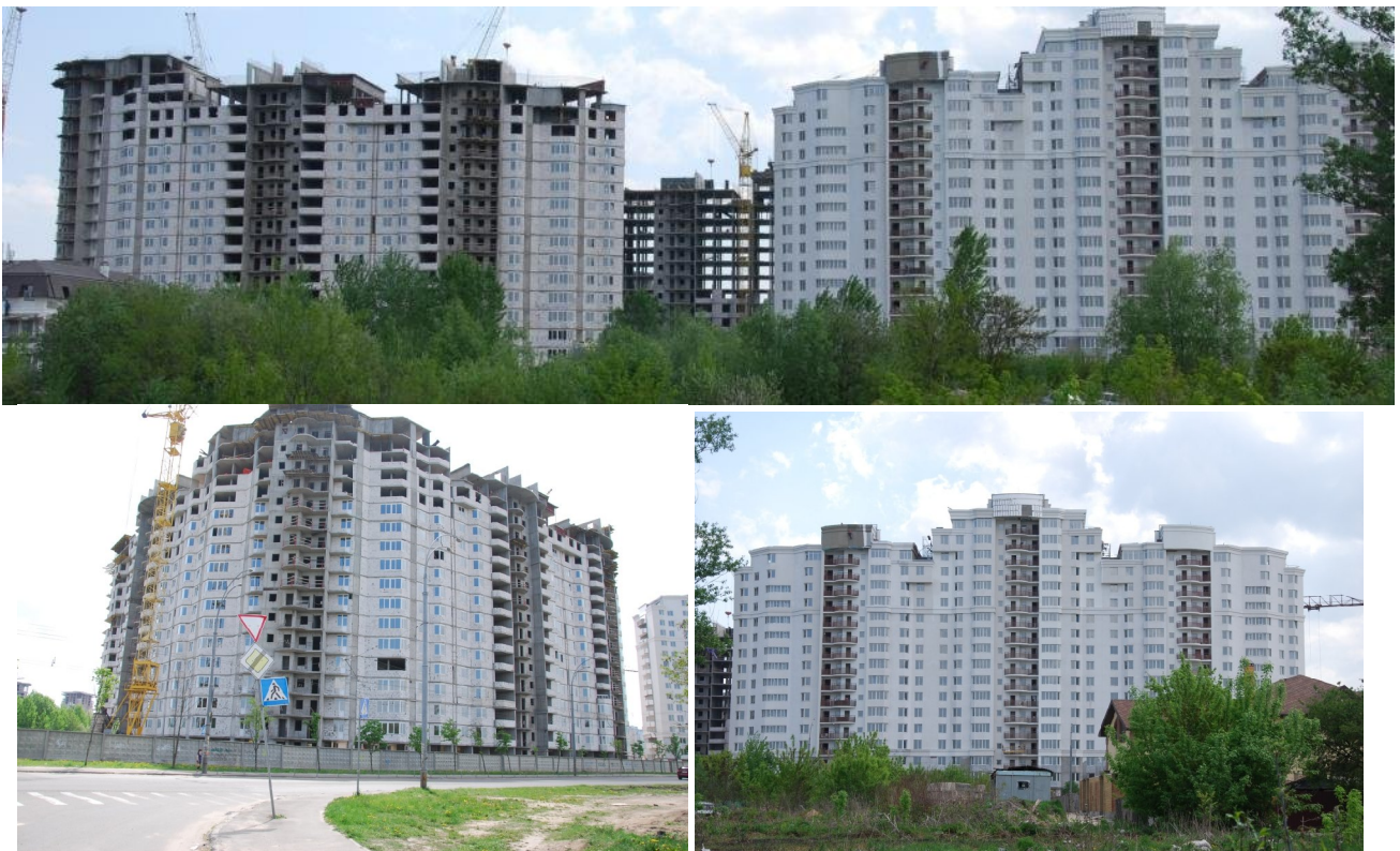
Рисунок 2. Стан будівництва житлових будинків з підземними паркінгами та закладів з обслуговування населення по вул. Вільямса,7 та вул. Ломоносова, 42-50 (III мікрорайон) у м. Києві станом на червень 2010 р.
