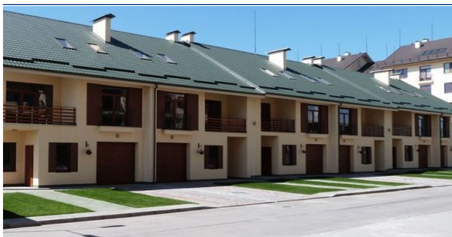
Житловий комплекс «Бородіно» по вул. Медичній у м. Запоріжжі станом на 22.08.2012 р. (житловий будинок №6)
