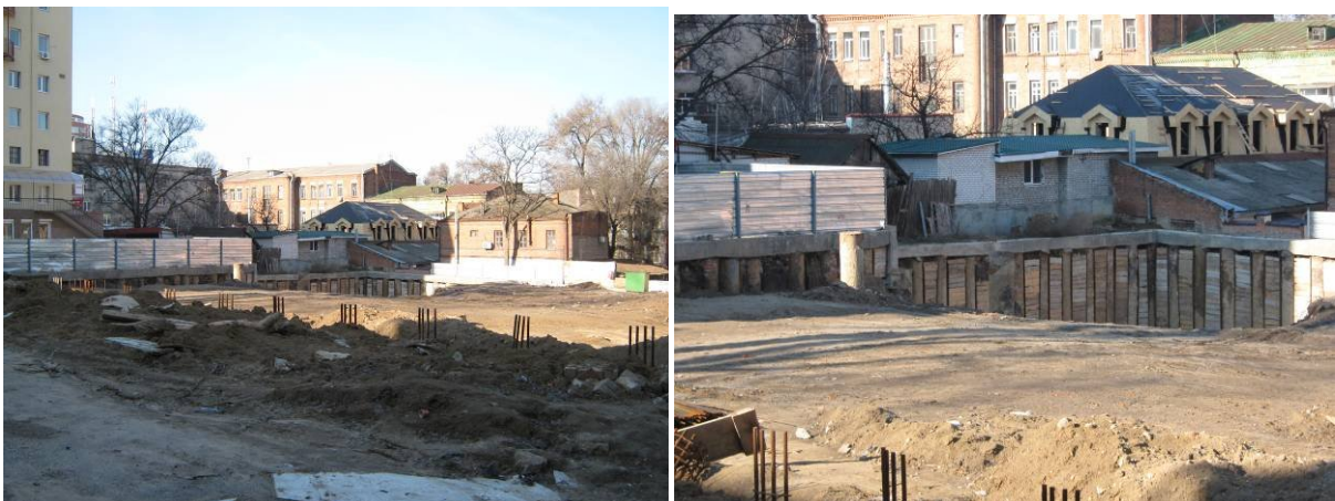
Хід робіт на об'єкті будівництва по вул. Шевченка у м. Дніпропетровську станом на 20.02.2009 р.
