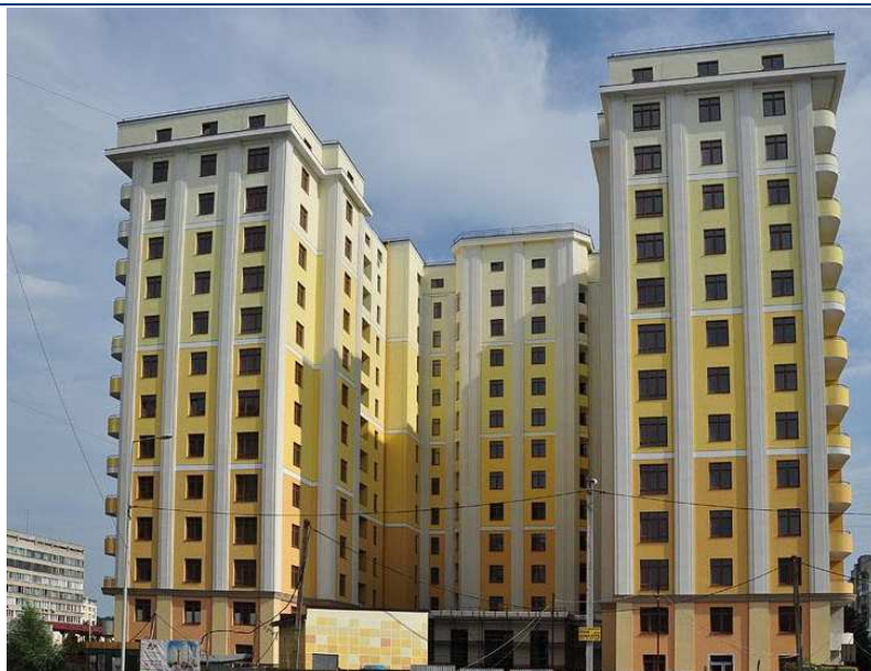
Багатоповерховий житловий будинок з вбудованими офісними приміщеннями та підземними автостоянками на пр. В. Чорновола – вул. П. Панча в м. Львові станом на кінець червня 2013 року
