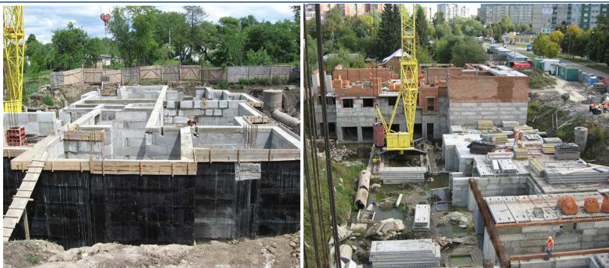
Хід будівництва 9-ти поверхового багатоквартирного житлового будинку з вбудованими приміщеннями громадського призначення по вул. А. Манастирського у м. Львові станом на середину травня 2013 року та початок вересня 2013 року (зліва направо)
