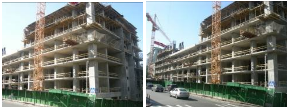
Будівельні роботи на об'єкті будівництва, обмеженого вулицями Предславинською, Ульянович та Червоноармійською станом на 21.08.2009 р.
