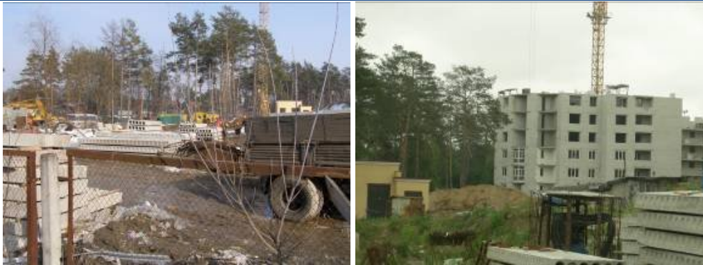
Будівництво житлового комплексу (II черга) по вул. Лобановського, 1 у с. Чайці Києво-Святошинського району Київської області станом на березня та травень 2010 року
