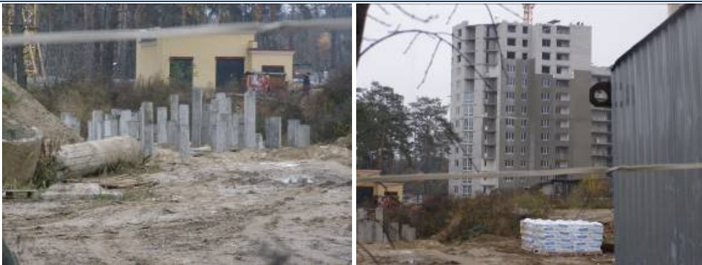
Будівництво житлового комплексу (II черга) по вул. Лобановського, 1 у с. Чайці Києво-Святошинського району Київської області станом на листопад 2010 року: будинки № 8 та 10 (зліва направо)
