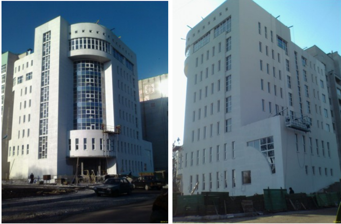
Житлово-офісний комплекс по вул. Перемоги, 99, м. Житомир, станом на 31.03.2009 р.
