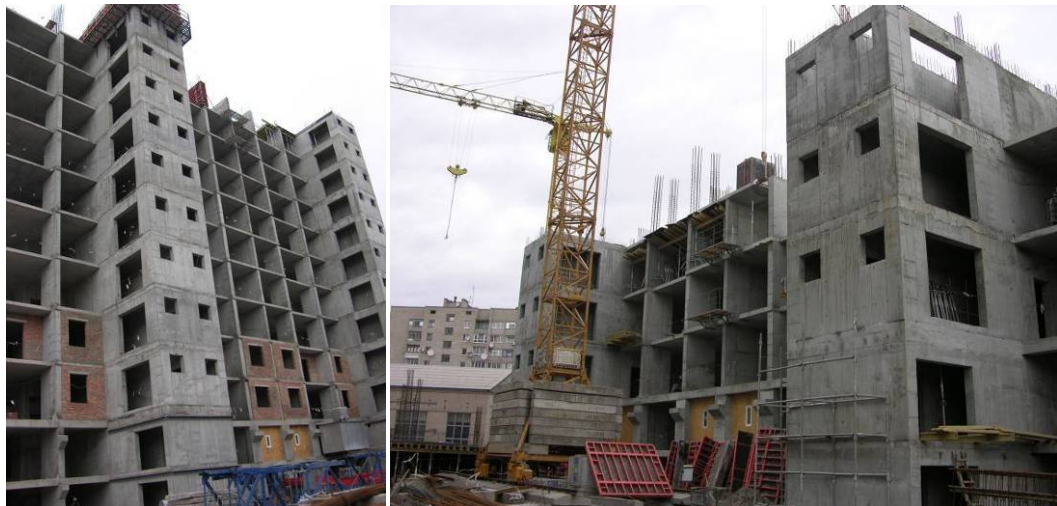
Хід робіт на об'єкті будівництва по пров. Ламаному в м. Дніпропетровську станом на 21.11.2008 р.
