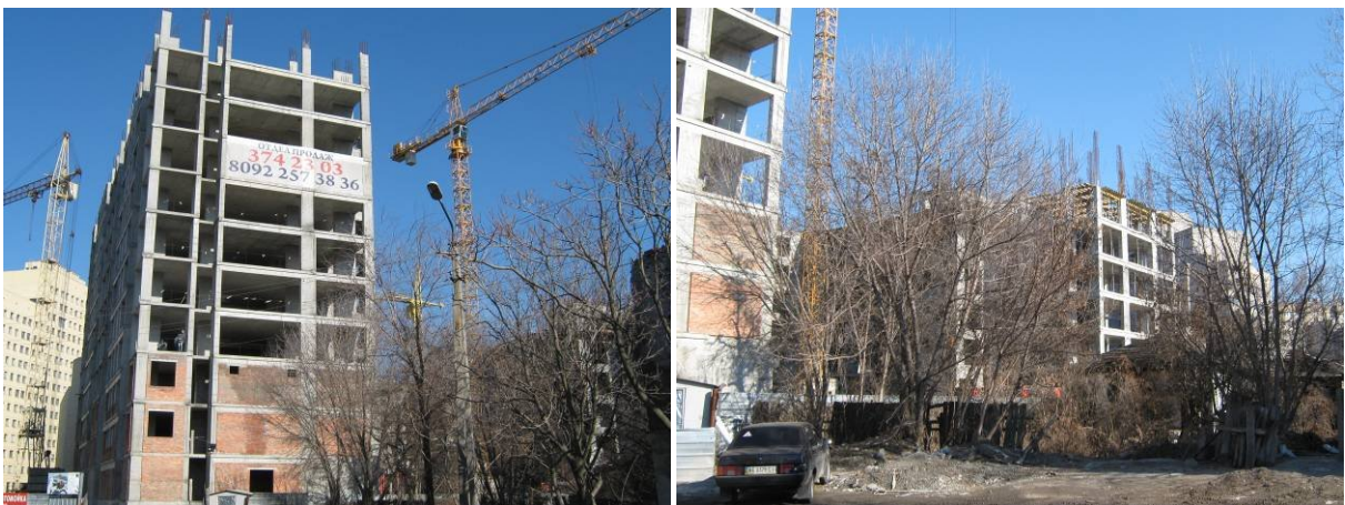
Хід робіт на об'єкті будівництва по пров. Ламаному в м. Дніпропетровську станом на 20.02.2009 р.
