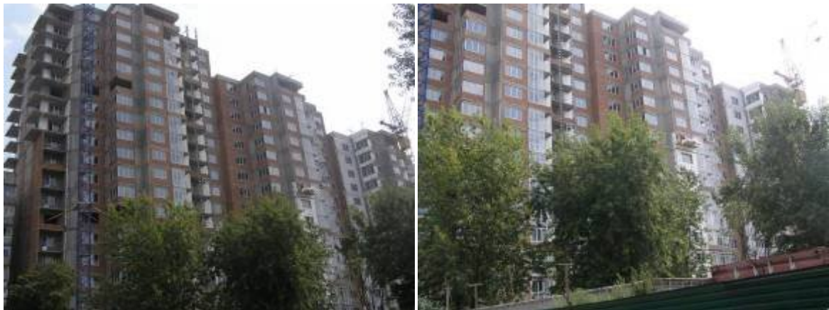
Будівництво житлового будинку по вул. Жовтневій, 31а станом на 28.08.2009 р.
