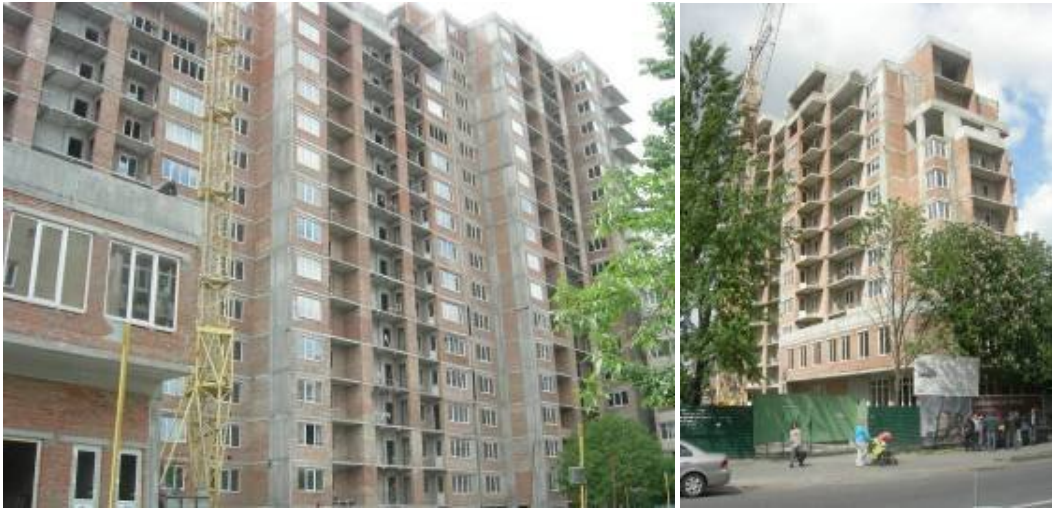
Будівництво житлового будинку по вул. Жовтневій, 31а станом на 18.05.2009 р.
