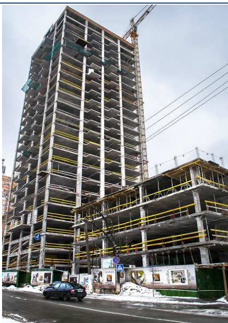
Хід будівництва житлово-офісного комплексу по вул. Воровського, 21 у м. Києві станом на кінець січня 2013 року
