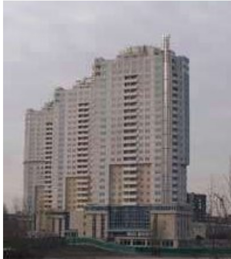
Будівництво об'єктів (секції I, II та III) по вул. Ю. Шумського
