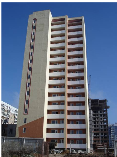
Рисунок 4. Житловий будинок № 28 у мікрорайоні III-4-2 Котовського у м. Одесі
