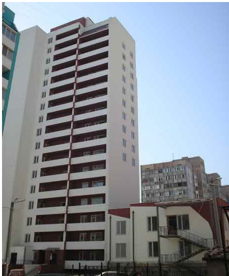
Рисунок 2. Житловий будинок № 30 у мікрорайоні III-4-2 Котовського у м. Одесі
