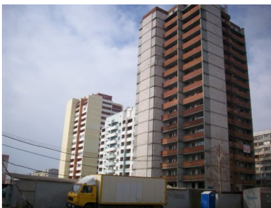
Рисунок 3. Стан будівельної готовності житлового будинку № 27 у мікрорайоні III-4-2 Котовського у м. Одесі станом на березень 2010 р.
