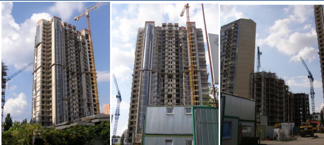
Будівництво житлово-офісного комплексу з вбудованими, прибудованими приміщеннями та підземним паркінгом по вул. Анрі Барбюса, 37/1 у Печерському районі м. Києва станом на середину серпня 2011 року
