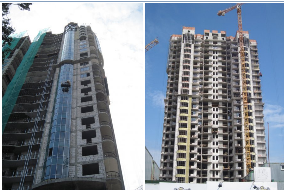
Будівництво житлово-офісного комплексу з вбудованими, прибудованими приміщеннями та підземним паркінгом по вул. Анрі Барбюса, 37/1 у Печерському районі м. Києва станом на середину травня 2011 року
