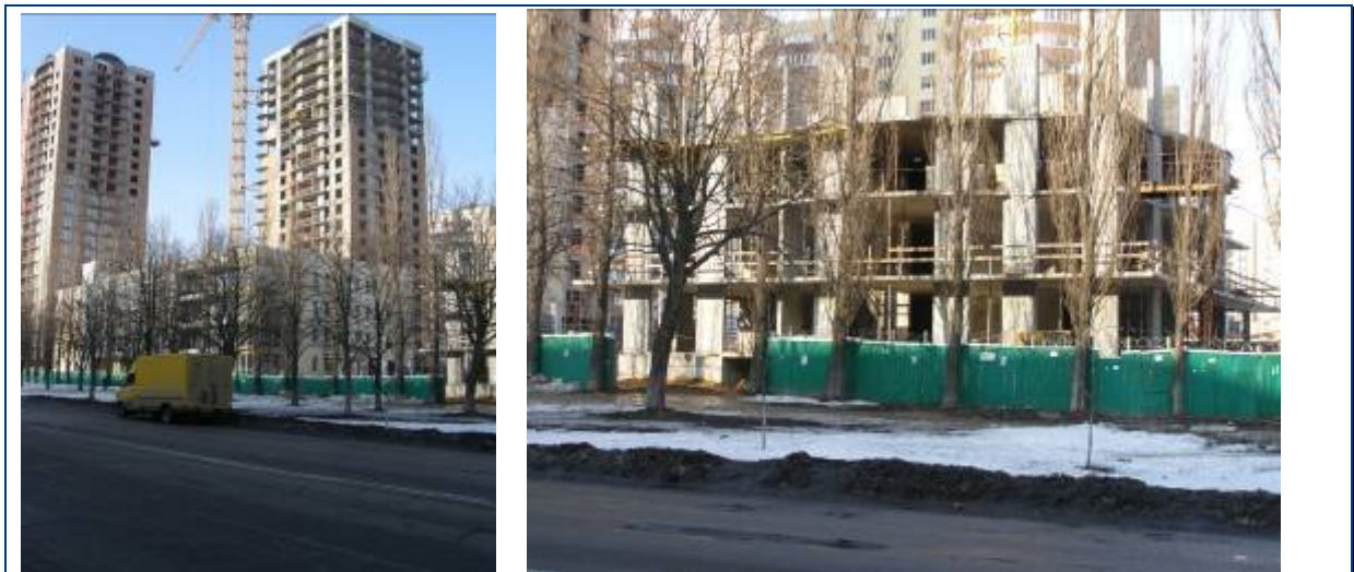
Будівельні роботи по житловим будинкам №№ 33 та 34 та № 35 станом на кінець березня 2010 року
