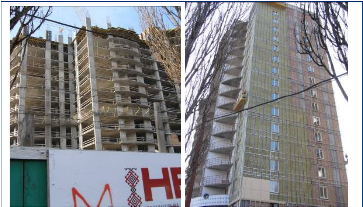
Будівельні роботи на секціях 1-3 житлового будинку № 26 станом на кінець березня 2010 року
