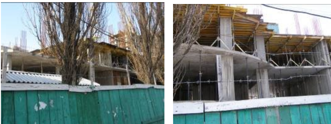
Будівельні роботи на секціях 1-4 житлового будинку № 28 станом на кінець березня 2010 року
