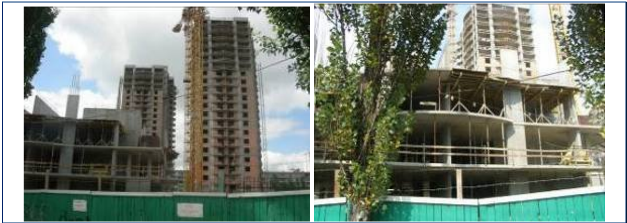
Будівельні роботи по житловим будинкам №№ 33 та 34 та № 35 станом на середину травня 2009 року та на кінець серпня 2009 року.
