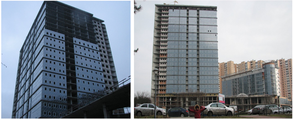
Рисунок 1.2. Будівельні роботи на об'єкті «Артеміда» за адресою м. Київ, перехрестя Дарницького бульвару та вул. Генерала Жмаченка станом на 20.02 2008 р.
