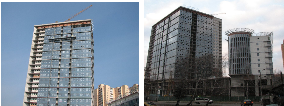
Рисунок 1.3. Будівельні роботи на об'єкті «Артеміда комплекс» за адресою м. Київ, перехрестя Дарницького бульвару та вул. Генерала Жмаченка станом на 30. 04.2009 р.
