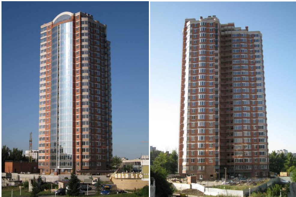
Будівництво житлового комплексу з підземним паркінгом по провулку Отакара Яроша у м. Харкові станом на 21.08.2009 р.
