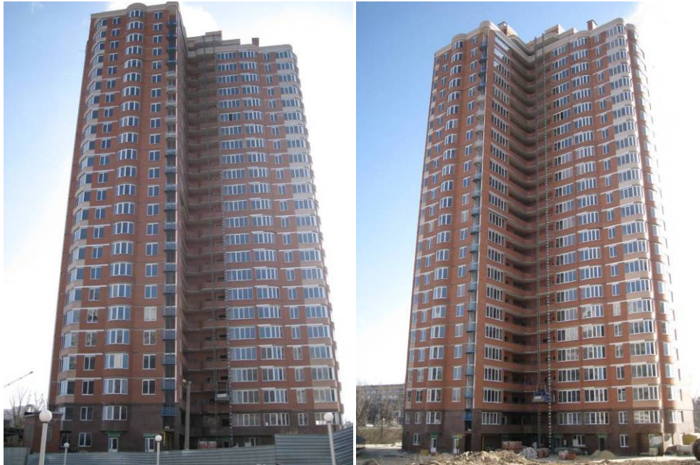
Будівництво житлового комплексу з підземним паркінгом по провулку Отакара Яроша у м. Харкові станом на 20.02.2009 р.
