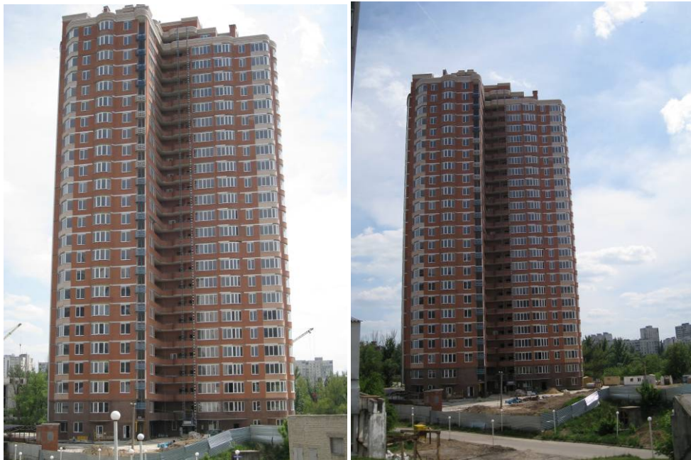
Будівництво житлового комплексу з підземним паркінгом по провулку Отакара Яроша у м. Харкові станом на 22.05.2009 р.
