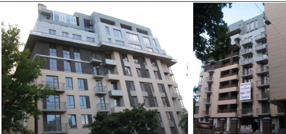
Будівництво житлового будинку по вул. Відрадній, 13 станом на початок червня 2011 року
