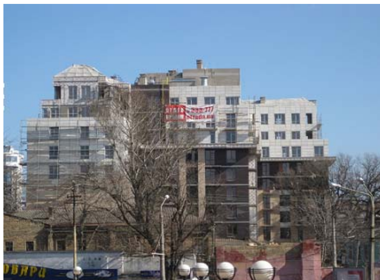
Будівництво житлового будинку по вул. Відрадній, 13 станом на початок березня 2011 року
