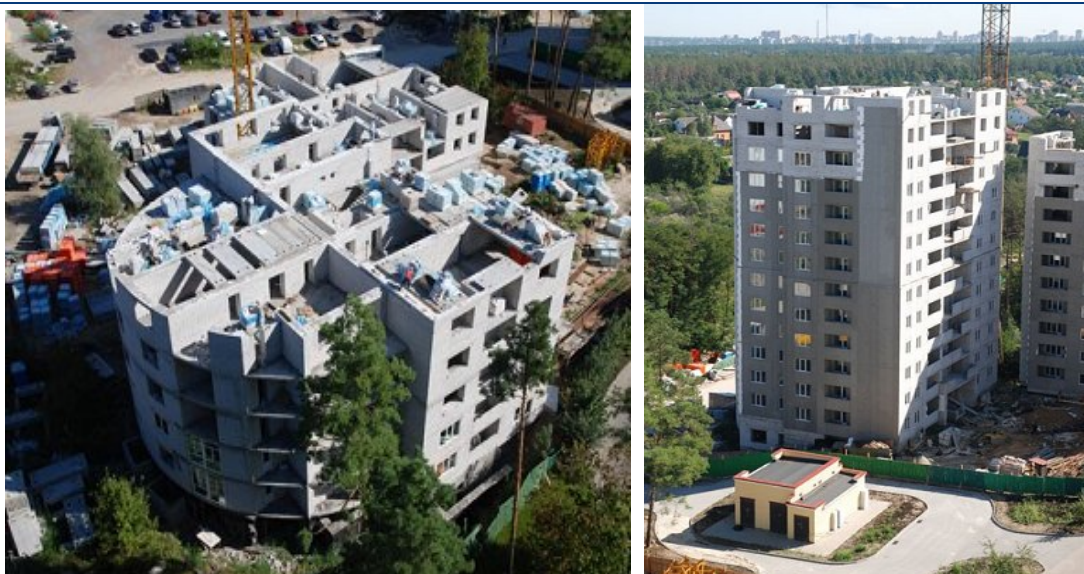
Будівництво житлового комплексу (II черга) по вул. Лобановського, 1 у с. Чайці Києво-Святошинського району Київської області станом на кінець серпня 2012 року (зліва на право: будинок №8, будинок №9)
