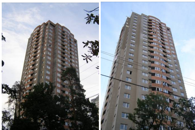
Рисунок 1.3. Хід робіт на об'єкті будівництва житлового будинку по вул. Львівській, 26 м. Київ станом на 24.06.2009 р.
