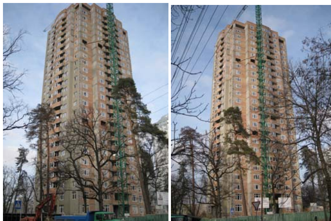
Рисунок 1.2. Хід робіт на об'єкті будівництва житлового будинку по вул. Львівській, 26 м. Київ станом на 05.03.2009 р.
