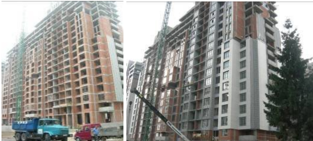
Хід робіт з будівництва ж/б 4 по вул. Професора Підвисоцького у Печерському районі м. Києва станом (зліва-направо): на 03.09.2009 р. та на 19.11.2009 р.
