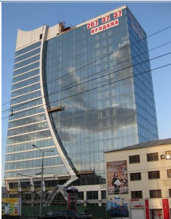
Хід робіт на об'єкті будівництва комплексу по вул. Артема (на перетині з пр. Ватутіна) в Ворошиловському районі м. Донецька станом на початок квітня 2012 року
