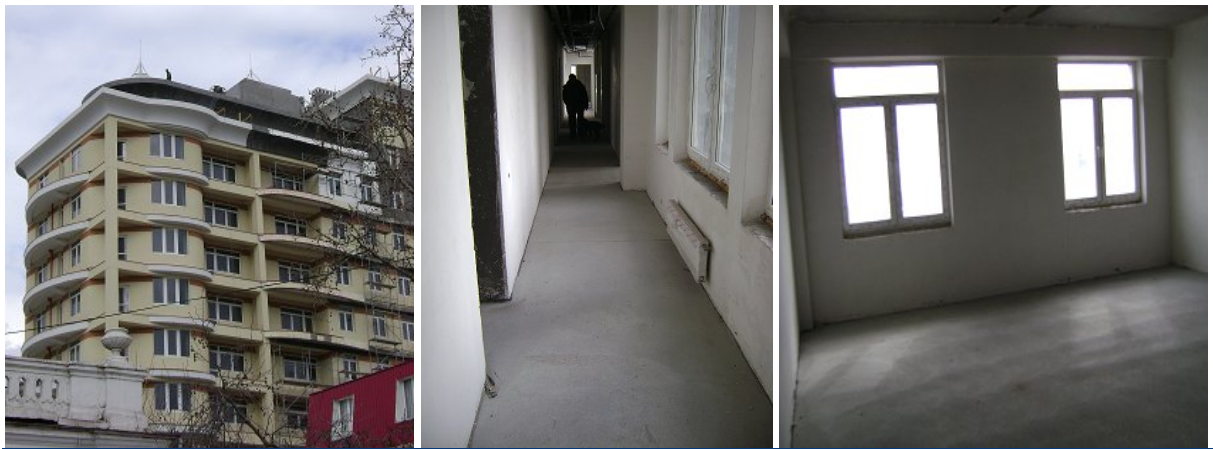
Хід робіт на об'єкті будівництва житлового комплексу «Адміралтейський» класу «люкс» по вул. Руданського, буд. 8 Б станом на 04.03.2010 р.
