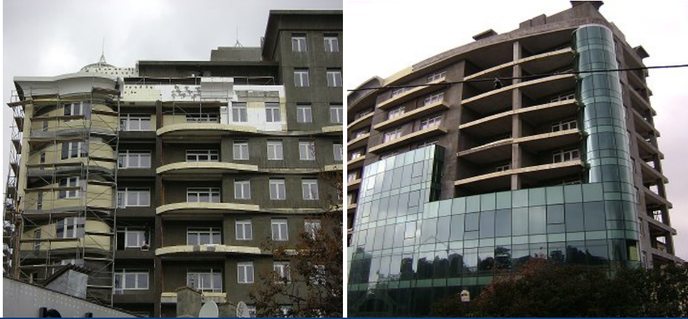
Хід робіт на об'єкті будівництва житлового комплексу «Адміралтейський» класу «люкс» по вул. Руданського, буд. 8 Б станом на 19.11.2009 р.
