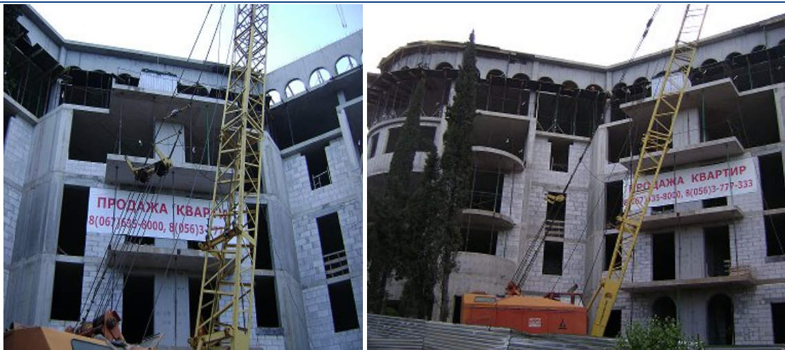
Стан будівництва житлового будинку по вул. Батуріна, 44А у смт. Лівадія м. Ялти станом на 04.06.2009 р.
