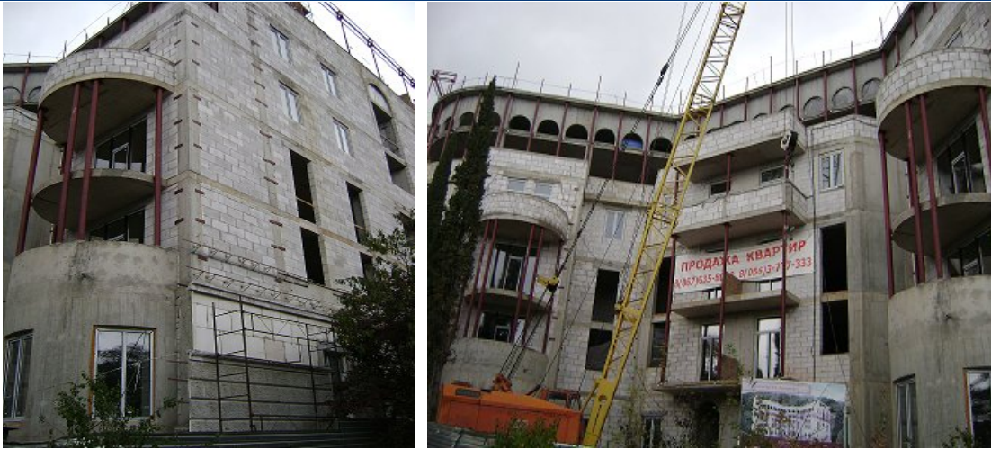
Стан будівництва житлового будинку по вул. Батуріна, 44А у смт. Лівадія м. Ялти станом на 19.11.2010 р.
