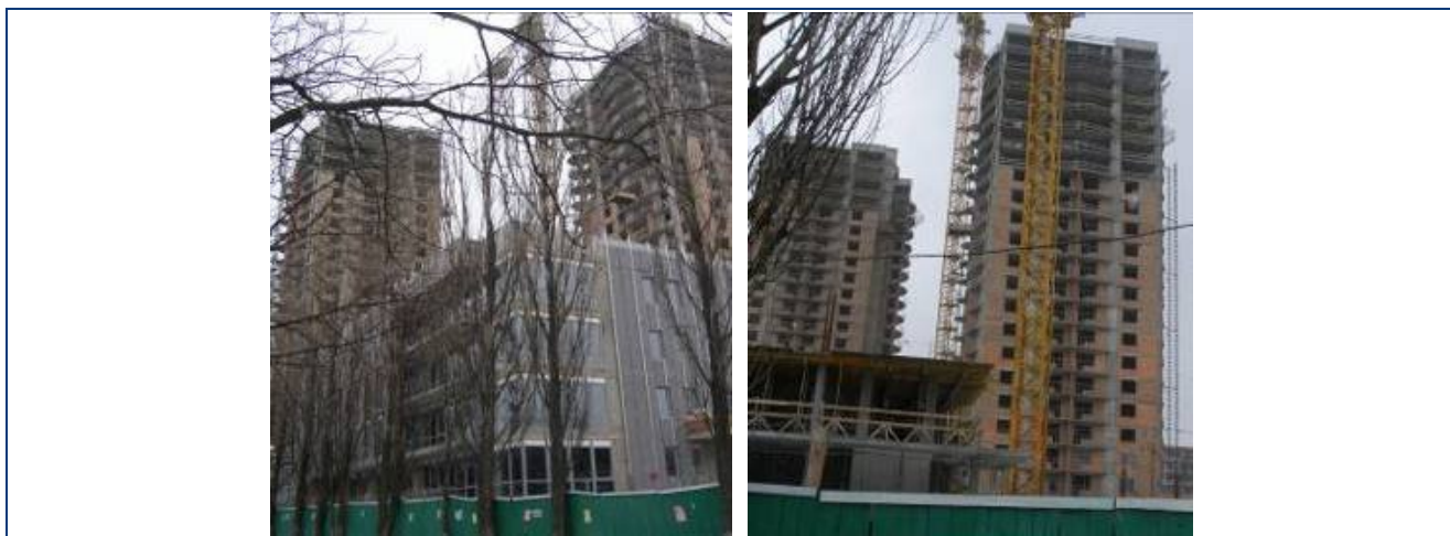
Будівельні роботи по житловим будинкам №№ 33 та 34 та адміністративному будинку № 36 станом на середину лютого 2009 року
