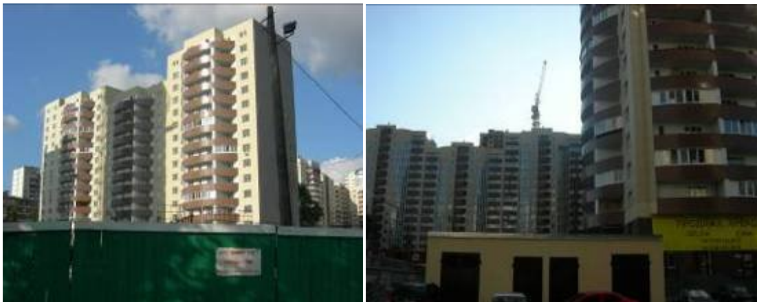
Секції 5-11 житлового будинку № 28
