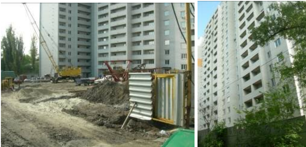
Об'єкт по вул. Дмитра Кедріна, в районі будинку №55, м. Дніпропетровськ станом на травень 2010 року
