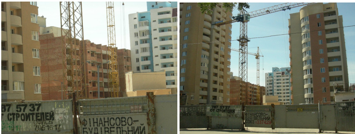
Рисунок 2. Стан будівництва громадсько-житлового комплексу у мікрорайоні ім. Таїрова на розі вул. 25-ї Чапаївської дивізії та просп. Маршала Жукова у м. Одесі на 27.08.2010 р.
