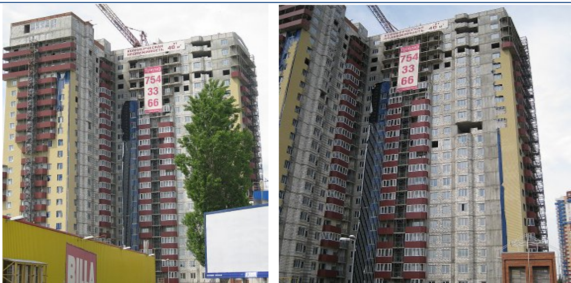
Рисунок Ошибка! Текст указанного стиля в документе отсутствует..2. Хід робіт на об'єкті будівництва по вул. 23 Серпня (в районі буд. 31) у м. Харкові станом на 22.05.2009 р.
