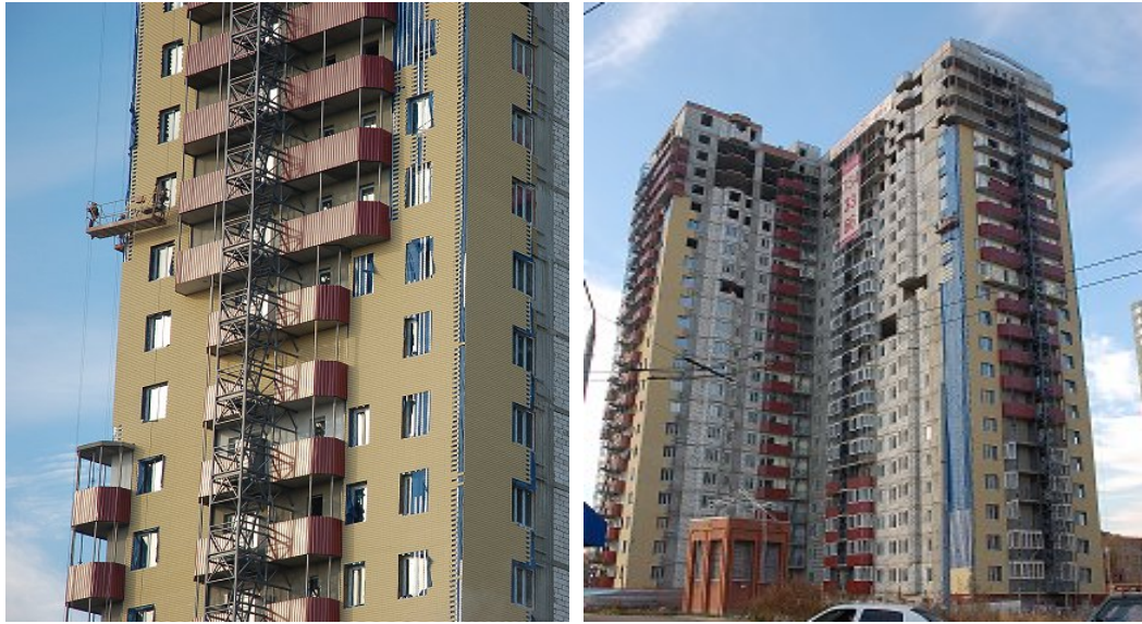
Рисунок Ошибка! Текст указанного стиля в документе отсутствует..1. Хід робіт на об'єкті будівництва по вул. 23 Серпня (в районі буд. 31) у м. Харкові станом на 15.01.2009 р.
