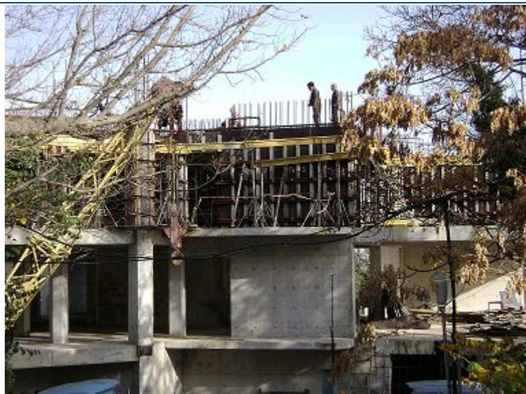
Хід будівництва рекреаційного комплексу по вул. Луговського в смт. Сімеїз станом на 12.11.2010 р.
