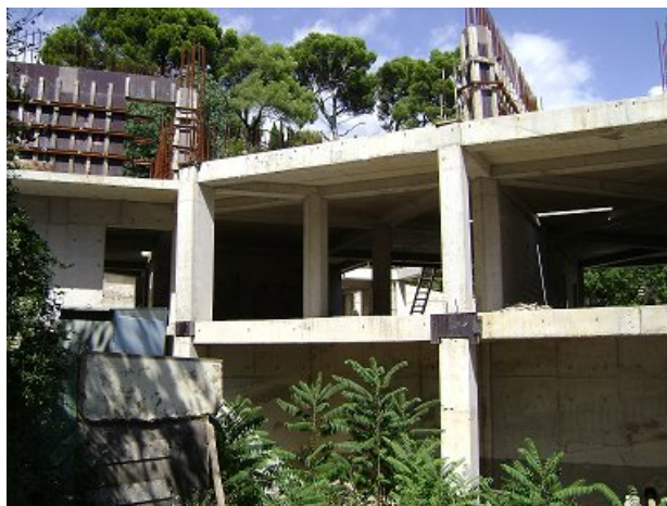
Хід будівництва рекреаційного комплексу по вул. Луговського в смт. Сімеїз станом на 27.08.2010 р.
