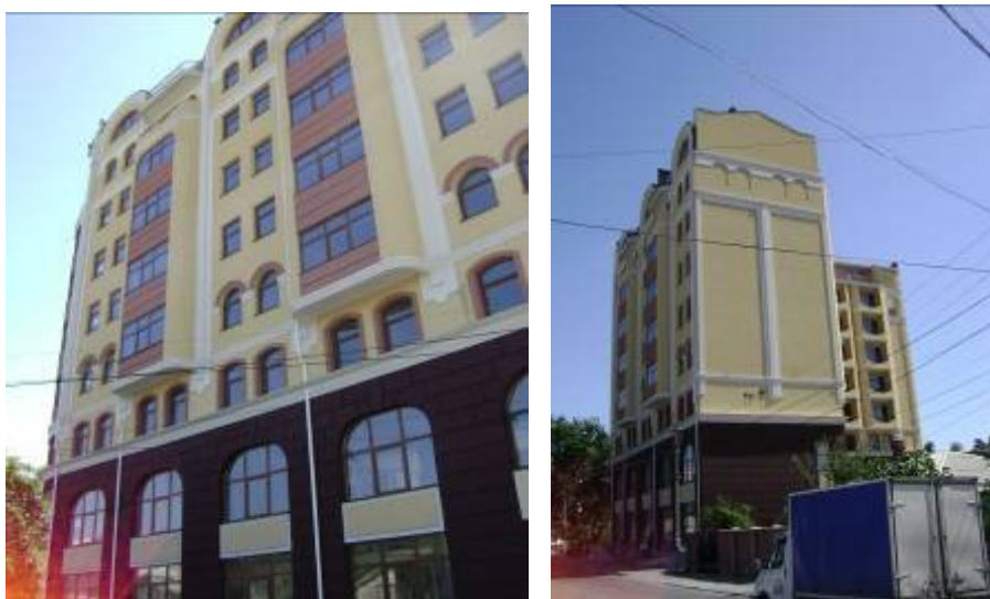
Рисунок 0.3. Об'єкт будівництва по вул. Баглікова в м. Алушті станом на кінець серпня 2009 року
