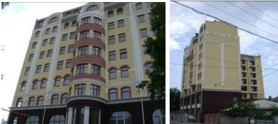
Рисунок 0.2. Хід робіт на об'єкті будівництва по вул. Баглікова у м. Алушті станом на початок червня 2009 року
