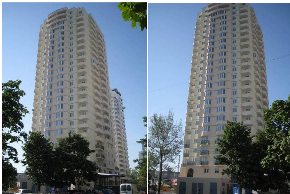
Будівництво житлового будинку у м. Києві на розі вулиці Героїв Дніпра та проспекту Героїв Сталінграду станом на 30.06.2009 р.
