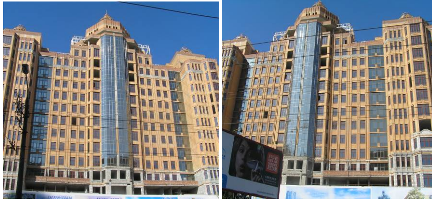
Будівельні роботи на об'єкті «Корона Нової Аркадії»
