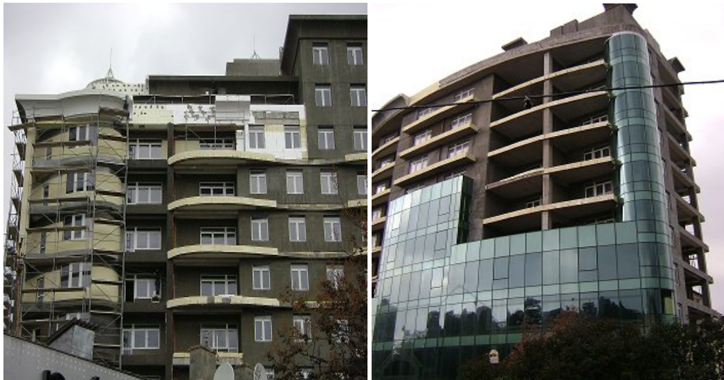
Хід робіт на об'єкті будівництва житлового комплексу «Адміралтейський» класу «люкс» по вул. Руданського, буд. 8 Б станом на 19.11.2009 року
